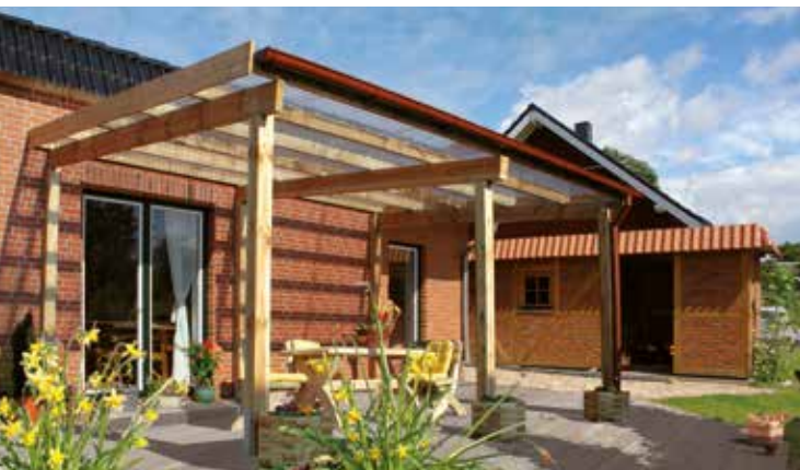
Das Terrassendach mit Profilplatten schafft Extraplatz – ideal als geschützter Treffpunkt zum Essen und Plaudern
