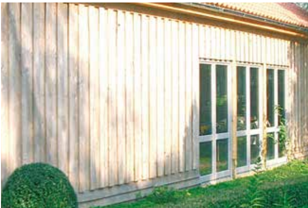
individueller Wandgestaltung (sogenannter „Boden-Deckel-Schalung“)
