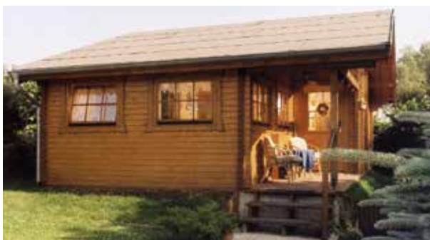
Seitenansicht „Holnis“ mit kleiner Treppe zum „Freisitz“ (bauseits)
