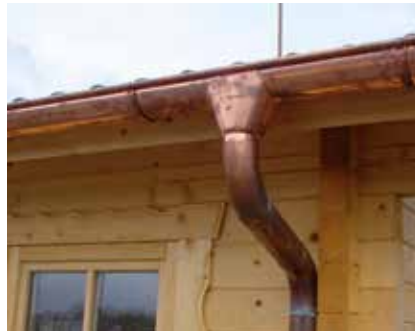
Individuell angepasstes Regenrinnen-Set aus Kupfer, Zink oder Stahl
