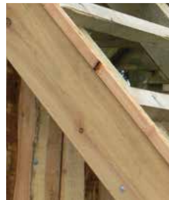
Lärchen – Dachstuhl im Detail
