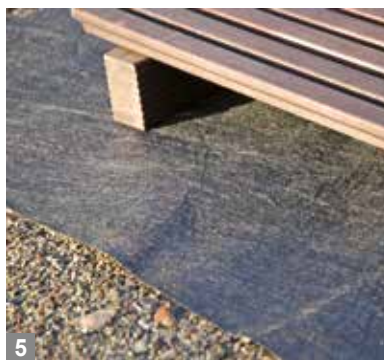
5 Wasserdurchlässiges Abdeckvlies gegen Durchwurzlung u. Pfützenbildung.
