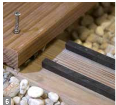
6 Praktisch: selbstklebendes Ausgleichsband reguliert Unebenheiten.
