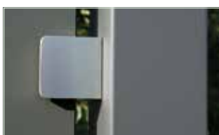
Detail-Ansicht zwischen Pfosten und Fassadenplatte HPL
